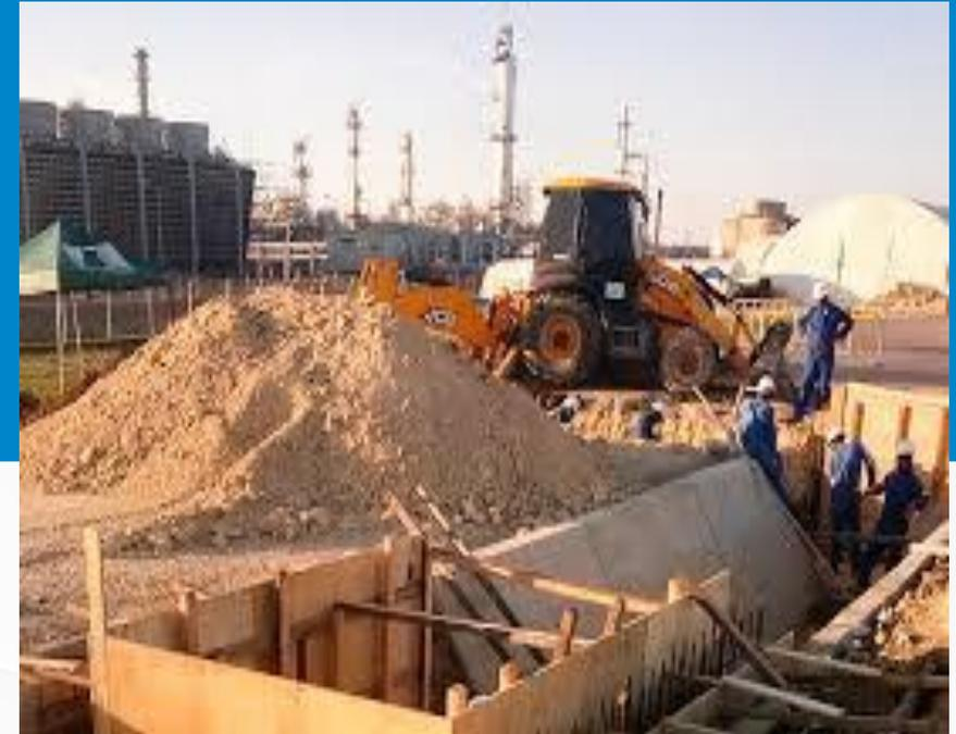
**Etapa de Adecuación y Mantenimiento: Remoción de cobertura vegetal y descapote y; Excavación, relleno y compactación del terreno**
