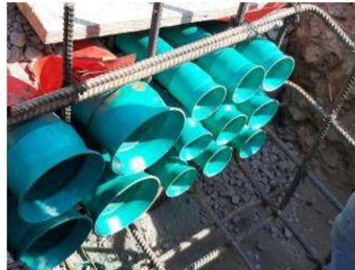
Fotografía 3-223 Tramos de bancos de ductos instalados
