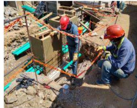
Fotografía 3-224 Trabajos de construcción en caja de distribución de energía para alumbrado exterior
