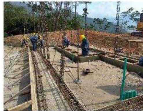
Fotografía 3-222 Armado de formoleta para vigas de arranque de mampostería
