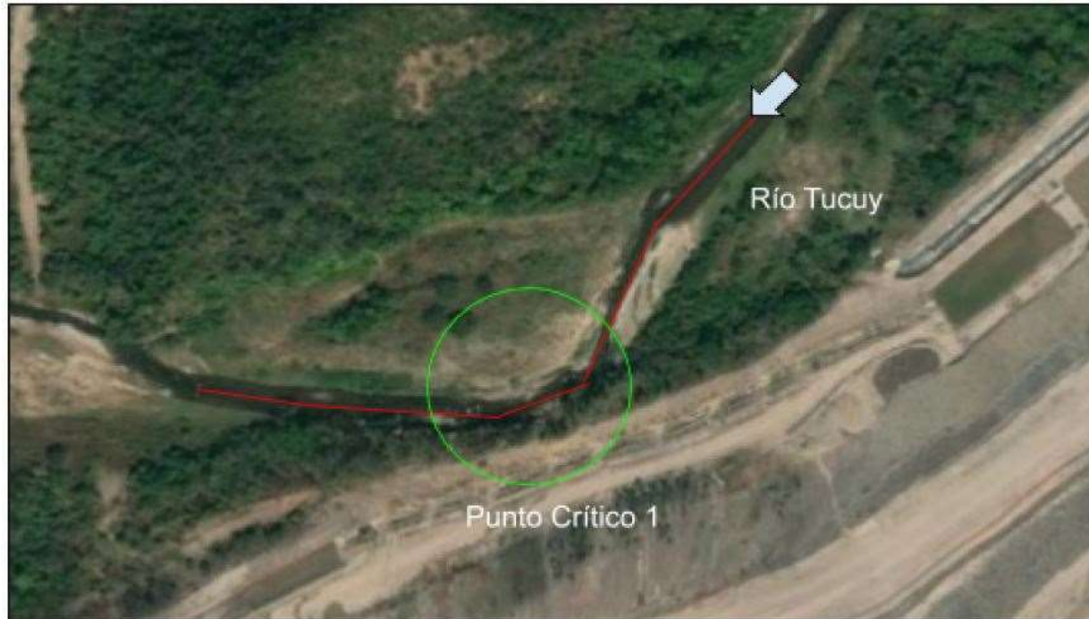
Figura 4. Punto crítico 1 antes de construcción de obra de protección
