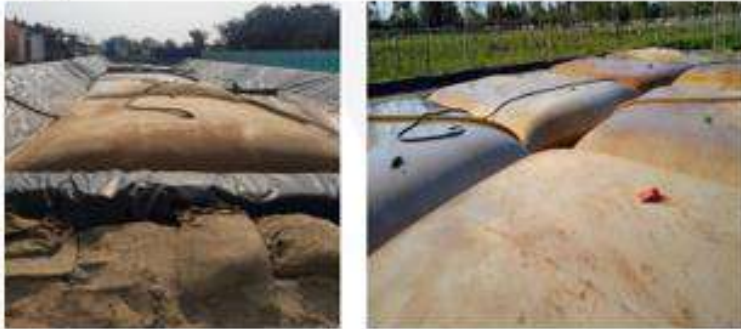
Fotografía 104 Geocontenedores para cortes de perforación
