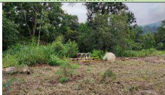
Fotografías. Acopio de material K0+100 Coordenadas Origen Único Nacional 4991520.43E, 2336179.18N
