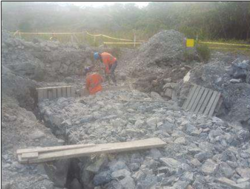
Imagen 1. Mantenimiento Filtro Frances
