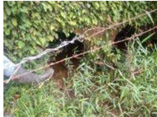
Fuente: EEA visita de verificación (23/11/2023), coordenadas Magna-Sirgas Origen Nacional - Norte: 1988505.26; Este: 4909747.02. Descrito como box culvert
