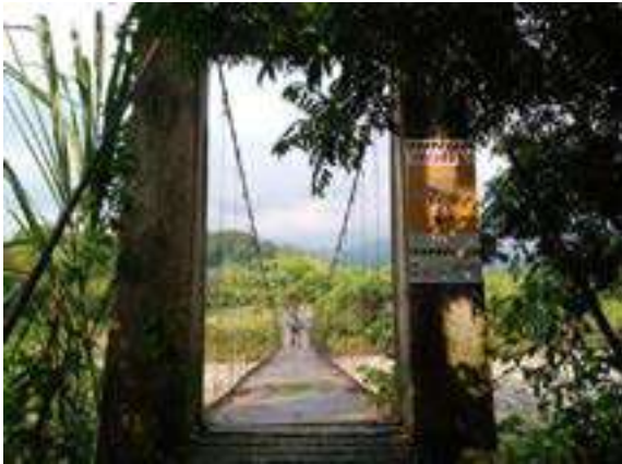
Fuente: EEA visita de verificación (23/11/2023), coordenadas Magna-Sirgas Origen Nacional - Norte: 1989337.92; Este: 4908820.51. Azimuth 275°. No cartografiado
