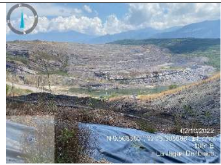
Fotografía 22. Sumidero Sur. Coordenadas origen único nacional E 4968575.849 N 2617905.839
