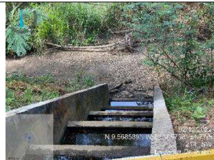
Fotografía 39. dissipador de energía vertimiento sur. Coordenadas origen único nacional E 4966462.412 N 2615355.918
