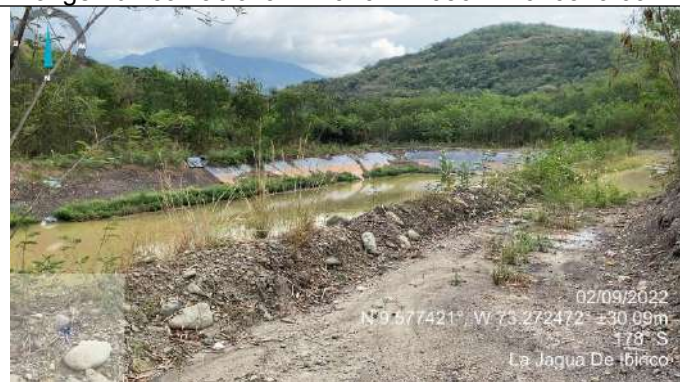
Fotografía 31. Piscinas Botadero Oriental. Coordenadas origen único nacional E 4970112.656 N 2616329.097
