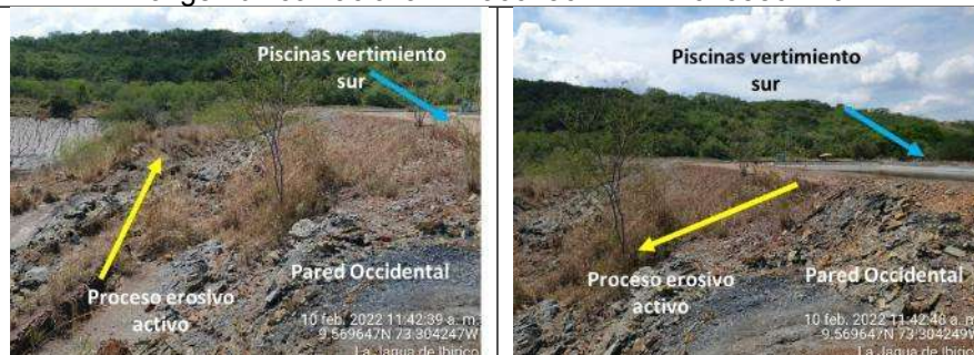
Fotografía 62. Proceso erosivo pared occidental PIT Sur. Coordenadas origen único nacional E 4966736.242 N 2615586.229
