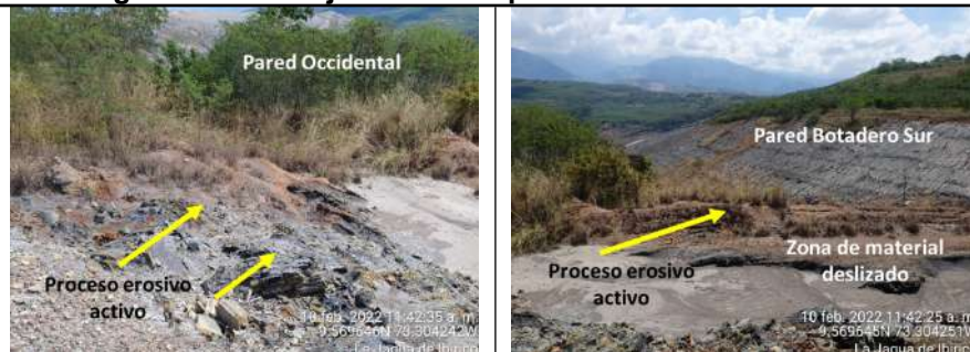
Fotografía 62. Proceso erosivo pared occidental PIT Sur. Coordenadas origen único nacional E 4966736.242 N 2615586.229
