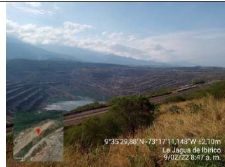
Fotografía 20. Sumidero Sur. Coordenadas origen único nacional E 4968575.849 N 2617905.839
