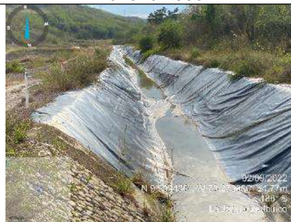
Fotografía 34. Canal al vertimiento norte. Coordenadas origen único nacional E 4970288.859 N 2618761.886
