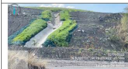
Fotografía 5 Bajante D1 Retrollenado.
