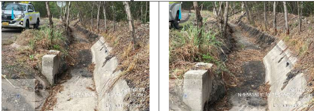
Fotografía 117. Canal del patio de ROM. Coordenadas E 4971649.613 N 2616812.348 origen único nacional.
