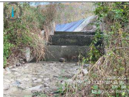
Fotografía 35. Dissipador de energía vertimiento norte. Coordenadas origen único nacional E 4970060.232 N 2618613.788
