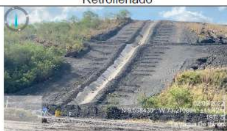
Fotografía 6 Bajante Central norte Retrollenado
