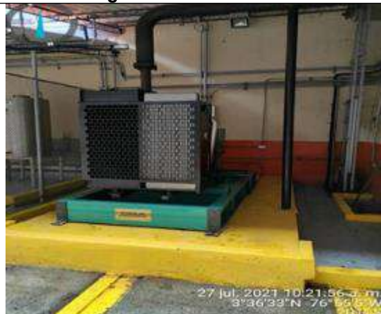
Fotografía 53 Planta eléctrica
