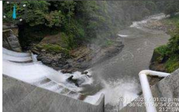
Fotografía 51 Estado del río Anchicayá aguas abajo de la presa
