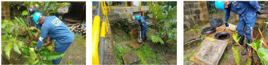
Imagen 41. Actividades de mantenimiento de la PTAR Sawerman
