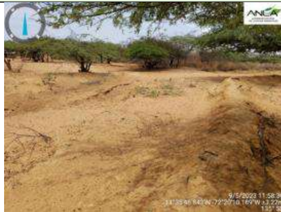
Fotografía 71. Vía de 1935 actual cauce intermitente y dique perimetral Coordenadas Magna Sirgas, origen Único E: 5072343 - N: 2839540
