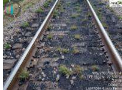
Fotografía 5. Línea férrea km 4 + 100 Coordenadas Magna Sirgas, origen Único E 5044714.550 - N 2791832.367
