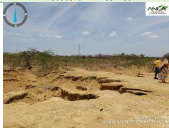
Fotografía 101. Procesos erosivos en la margen izquierda Coordenadas Magna Sirgas, origen Único E: 5098519 - N: 2892293
