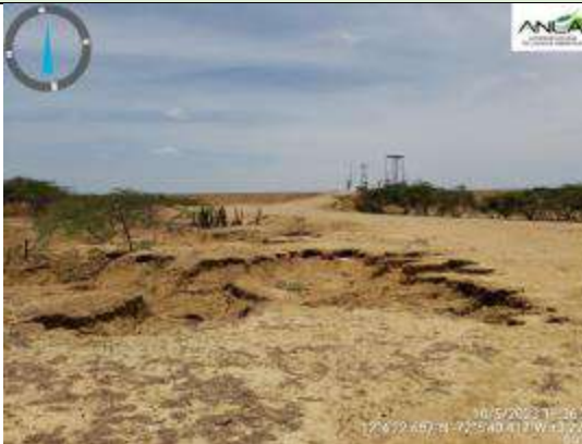
Fotografía 99. Procesos erosivos en la margen izquierda Coordenadas Magna Sirgas, origen Único E: 5098503 - N: 2892301
