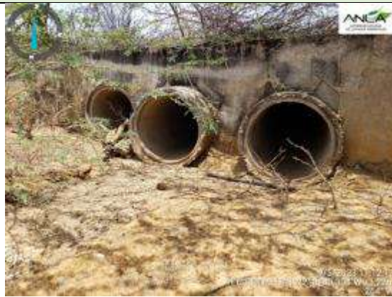
Fotografía 58. Panorama encole alcantarilla vía vehicular en el K65+190 Coordenadas Magna Sirgas, origen Único E: 5073249 - N: 2839146
