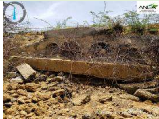
Fotografía 59. Panorama descole alcantarilla vía vehicular en el K65+190 Coordenadas Magna Sirgas, origen Único E: 5073220 - N: 2839145
