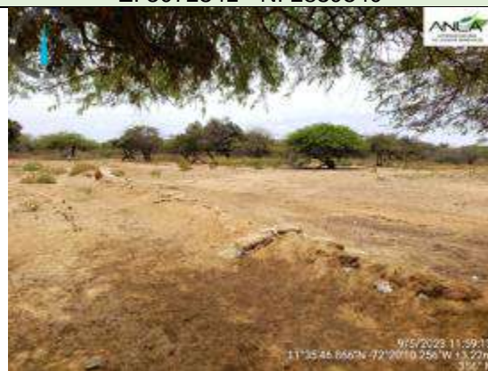
Fotografía 75. Dique de prevención de inundaciones Coordenadas Magna Sirgas, origen Único E: 5072341 - N: 2839540
