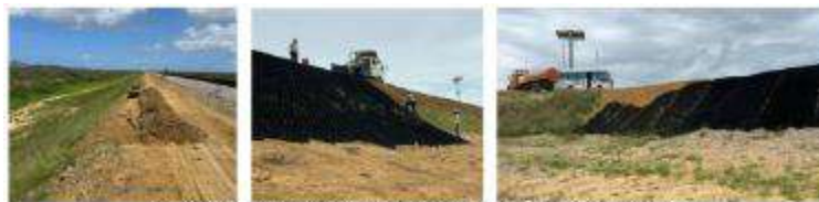
Proceso constructivo de la estabilización de taludes con instalación de celdas Geoweb Km124 - Km129
