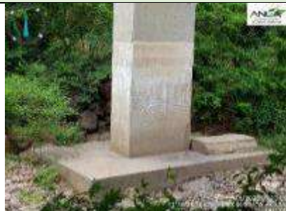
Fotografía 7. Línea férrea km 7 Río Ranchería Coordenadas Magna Sirgas, origen Único E 5047998.169 - N 2792876.069
