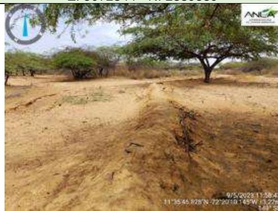
Fotografía 73. Dique de prevención de inundaciones Coordenadas Magna Sirgas, origen Único E: 5072344 - N: 2839539
