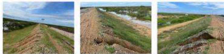
Construcción reportada Km 124 - Km 129. Tránsito en pendiente, aplicación por barridos de cárcavas compactando la estabilización de la misma
