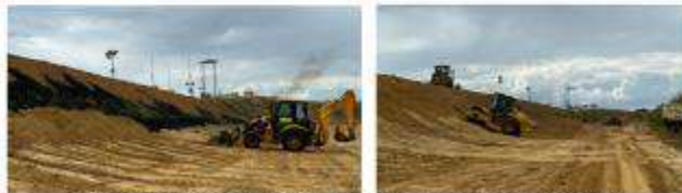
Proceso constructivo de la estabilización de taludes con instalación de celdas Geoweb Km124 - Km129
