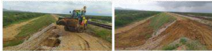
Aplicación Km 124 - Km 129. Mezcla de arcilla y conformación de rasante.
