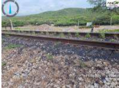
Fotografía 4. Línea férrea km 4+ 100 Coordenadas Magna Sirgas, origen Único E 5044714.550 - N 2791832.367
