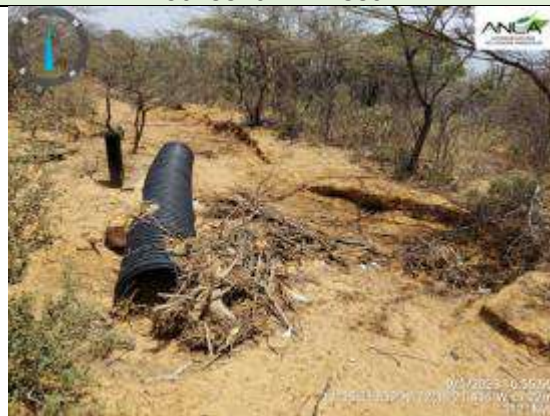
Fotografía 53. Cauce intermitente Coordenadas Magna Sirgas, origen Único E: 5073820 - N: 2839144
