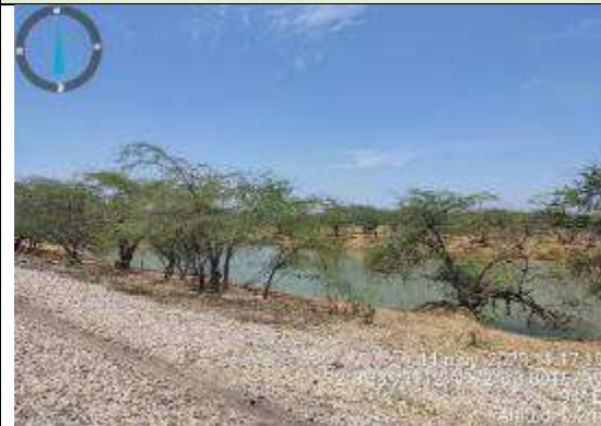
Fotografía 34. Percepción visual Jaguey No 10 (Km 122+640) – Línea férrea Coordenadas Magna Sirgas, origen Único E 5097824.88 - N 2890948.12
