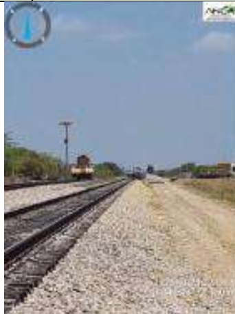
Fotografía 10. Cambio de balasto Aparcadero Kocinas K108+780
