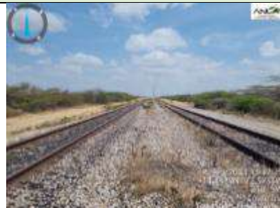
Fotografía 6. Línea férrea km 46 Coordenadas Magna Sirgas, origen Único E 5066151.991 - N 2822564.649
