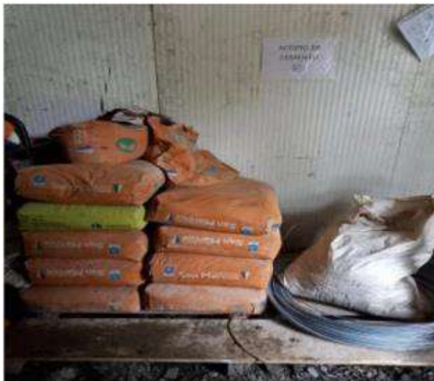
Figura 20 Acopio de cemento en actividades de estabilización del foco erosivo BA-03
