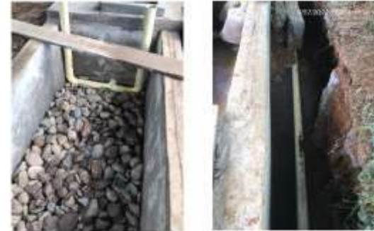
Fundición e instalación de rejilla en concreto filtro fitopedológico.
