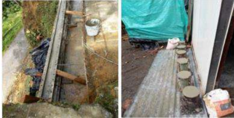
Figura 21 Uso de geotextil y plataformas metálicas para la mezcla de concreto
