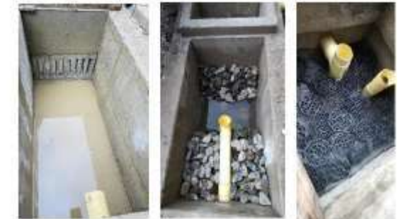
Instalación de piedra y rosetones plásticos en filtro fitopedológico y anaeróbico
