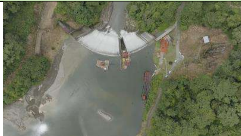
Fotografía 35. 18 Cobertura vegetal alrededor de la Presa
