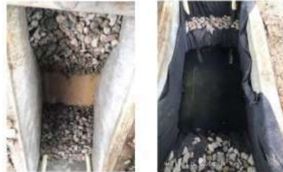
Instalación de piedra y geotextil, prueba de estanqueidad, filtro fitopedológico.
