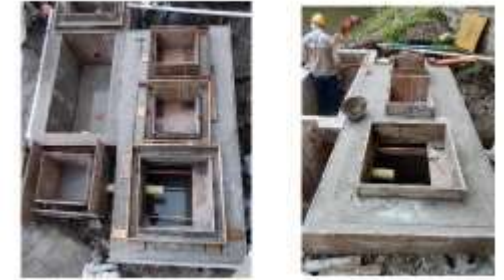
Instalación de piedra y rosetones plásticos en filtro fitopedológico y anaeróbico
