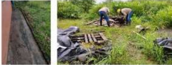
Instalación piedra y geotextil filtro fitopedológico, conformación terreno.
