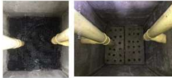
Instalación de piedra y geotextil, prueba de estanqueidad, filtro fitopedológico.
