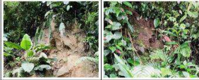
Fotografía 14. Foco erosivo BA-12. Movimiento en masa de tipo caída de rocas. Fuente: Geoservicios, 2022.
