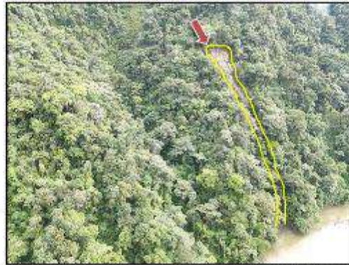
Fotografía 18. Foco erosivo BA-16. Movimiento en masa de caída de rocas. Fuente: Geoservicios, 2020.
