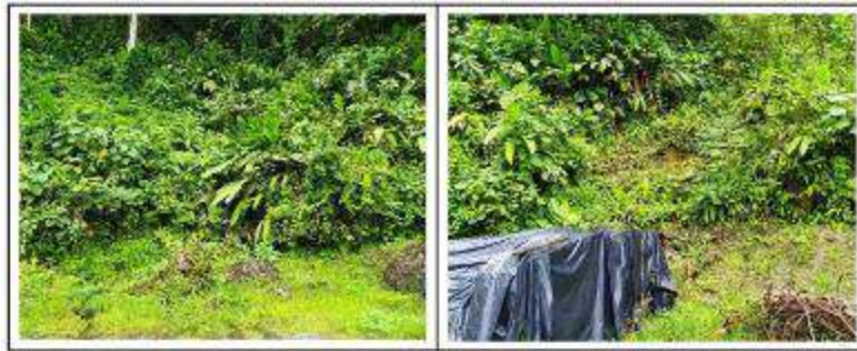
Fotografía 6. Foco erosivo BA-04. Movimiento en masa por desprendimiento de rocas.
