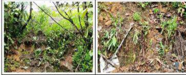
Fotografía 12. Foco erosivo BA-10. Movimiento en masa de caída de rocas.
