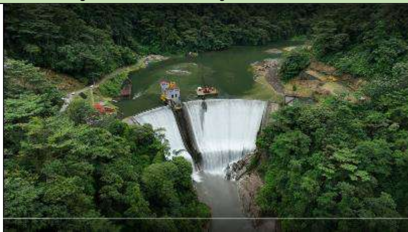
Fotografía 34. Cobertura vegetal alrededor de la Presa
