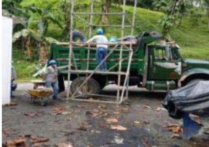
Figura 17 Carpado de material transportado en volqueta
