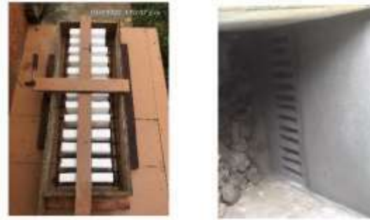
Fundición e instalación de rejilla en concreto filtro fitopedológico.
