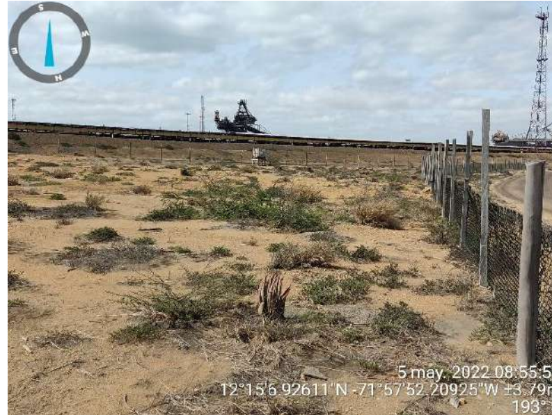
Lote No. 16 – Estado rehabilitación visita 2022
