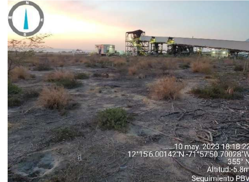
Lote No. 16 – Estado rehabilitación visita 2023
