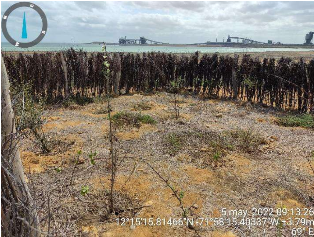
Lote No. 13– Estado rehabilitación visita 2022
