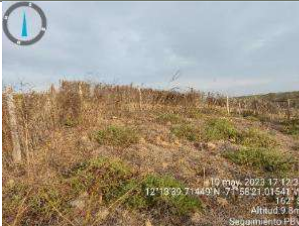
Fotografía 47. Lote No. 100 – Estado de rehabilitación Coordenadas Magna Sirgas, origen Único E 5111718.21 - N 2909453.19
