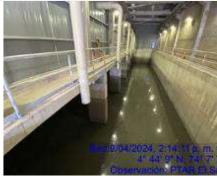
Fotografía 47. Aumento del nivel del agua residual en la zona de retención de sólidos muy gruesos
