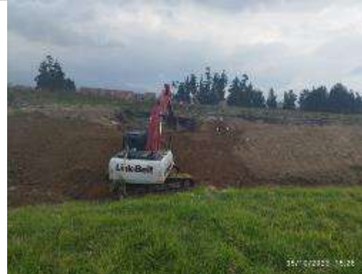
Fotografía 2. Maniobras con retroexcavadora de oruga Fecha: 05 de octubre de 2023 Lugar: Celda 7 – Predio la Magdalena Observación: Labores de perfilamiento celda con retroexcavadora de oruga
