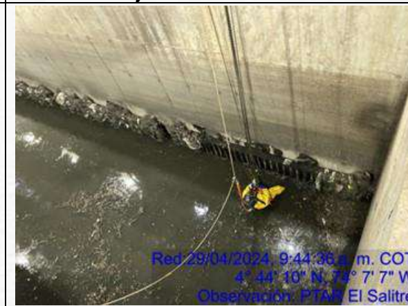
Fotografía 68. Retiro de sólidos gruesos de las rejillas en forma manual
