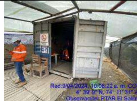
Fotografía 55. Container para el almacenamiento de herramientas, equipo y control operacional.
