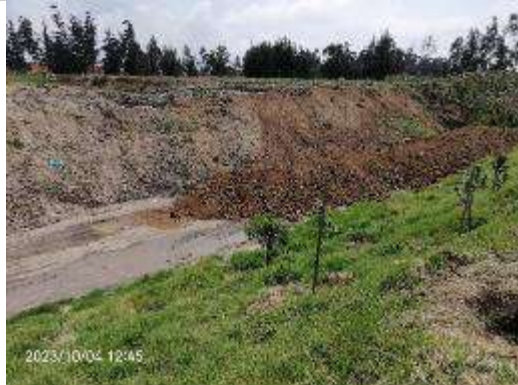
Fotografía 1. Inicio de labores de perfilación Fecha: 04 de octubre de 2023 Lugar: Celda 7– Predio la Magdalena Observación: Labores de perfilamiento celda
