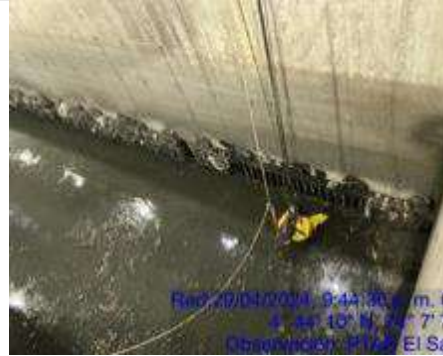
Fotografía 48. Retiro de sólidos gruesos de las rejillas en forma manual
