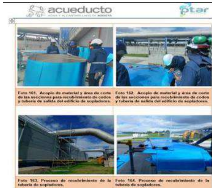
Fotografía 18. Insonorización de la tubería- Edificio sopladores
