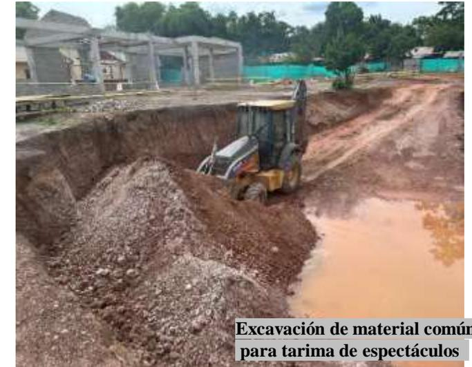
Excavación de material común para tarima de espectáculos
