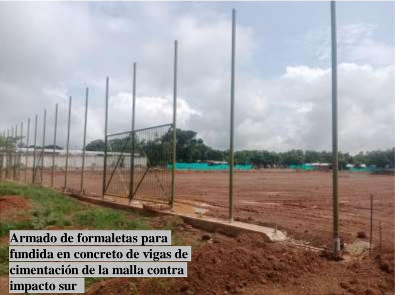
Armado de formaletas para fundida en concreto de vigas de cimentación de la malla contra impacto sur
