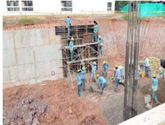
Fundida en concreto de cuerpo de muro de contención tipo 2 en la tarima de espectáculos
