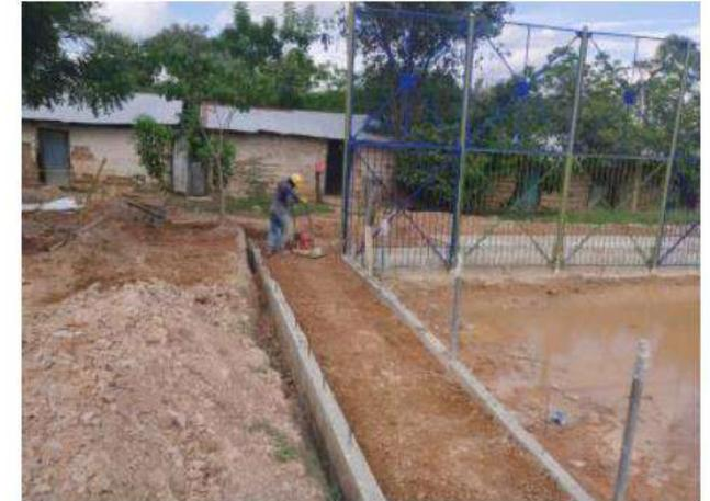
Relleno y compactación de material común para andenes en rampa en el costado occidental
