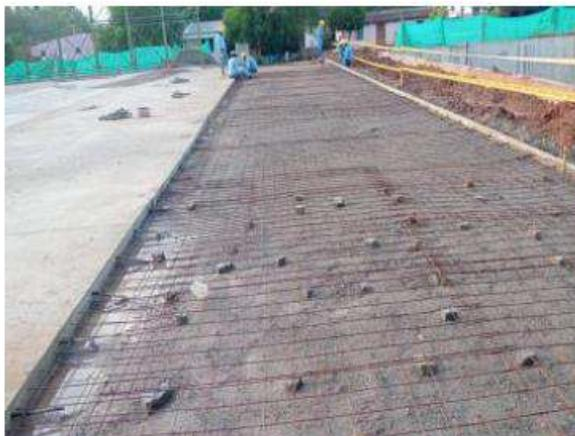
Instalación de malla electrosoldada para losa en hormigón de la cancha multifuncional
