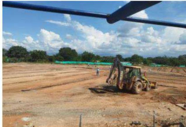
Excavación de material común hasta alcanzar cota de diseño
