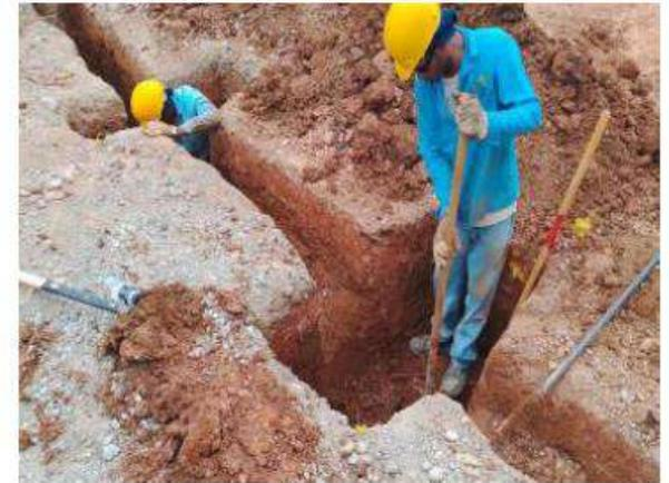
Excavación de material común para zapatas de la malla contra impacto en el costado sur
