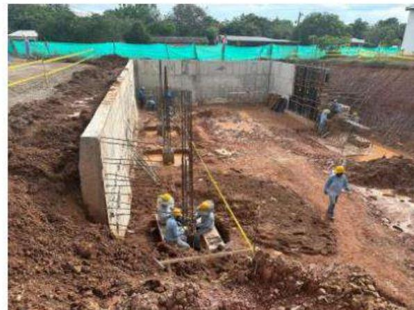
Armado de acero de refuerzo para columnas de la tarima de espectáculos
