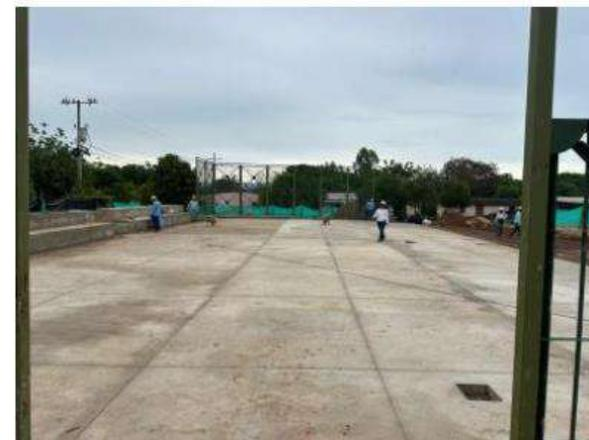
Fundida en concreto para losa en hormigón de la cancha multifuncional
