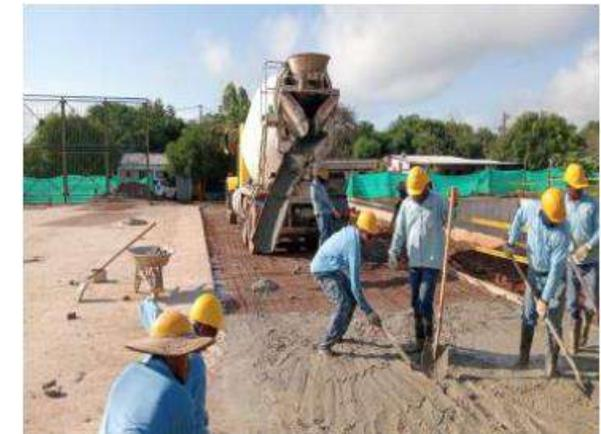
Fundida para losa en hormigón de la cancha multifuncional
