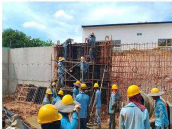
Fundida en concreto para cuerpo de muro de contención tipo 1 en el costado occidental de la tarima de espectáculos
