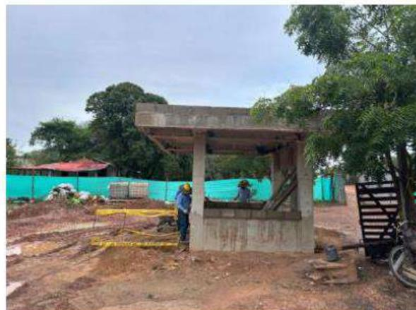
Levante en bloque de concreto para muros del kiosco 1
