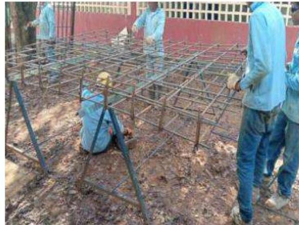
Armado de acero de refuerzo para zapata de muro de contención tipo 3 de la tarima de espectáculos
