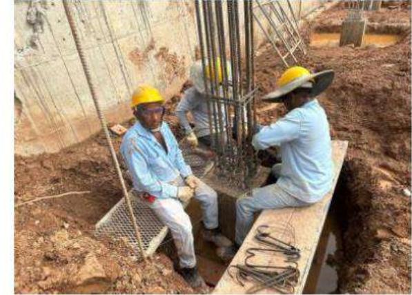
Armado de acero de refuerzo para columnas de la tarima de espectáculos
