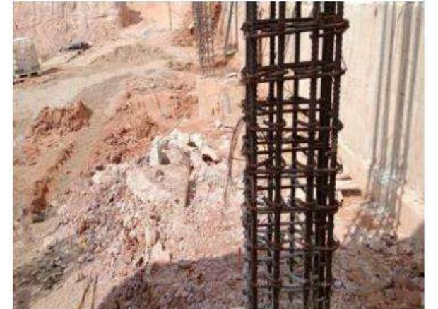
Instalación de acero de refuerzo para columnas de la tarima de espectáculos
