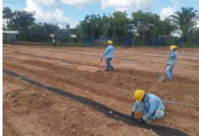
Sellado de geotextil luego de la instalación de la tubería de drenaje perforada 4"
