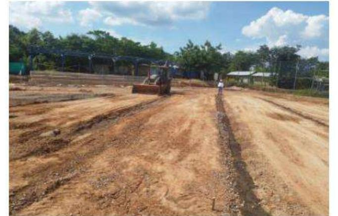
Excavación de material común hasta alcanzar cota de diseño
