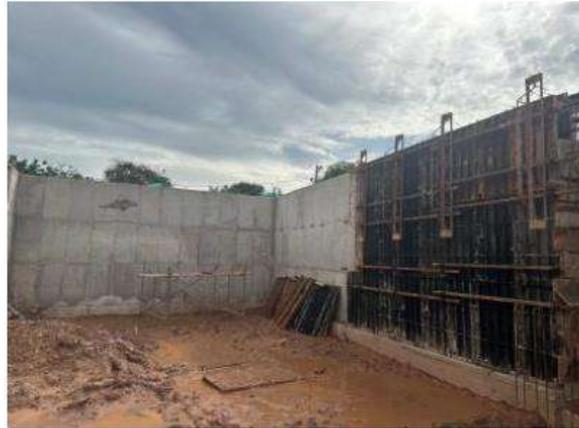
Armado de formaletas para fundida de cuerpo de muro de contención tipo 1 en el costado occidental de la tarima de espectáculos
