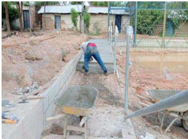
Fundida en concreto para andenes en rampa en el costado occidental
