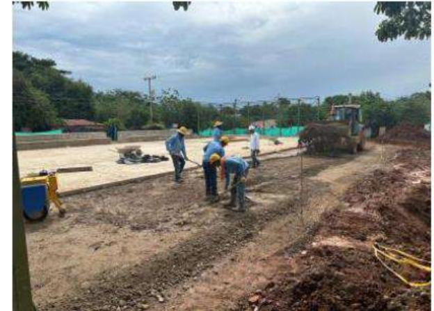
Relleno y compactación de sub-base para losa en hormigón de la cancha multifuncional
