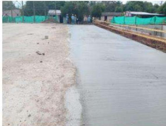
Fundida para losa en hormigón de la cancha multifuncional
