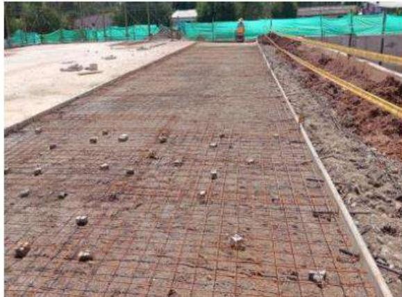
Instalación de malla electrosoldada y armado de formaletas para losa en hormigón de la cancha multifuncional
