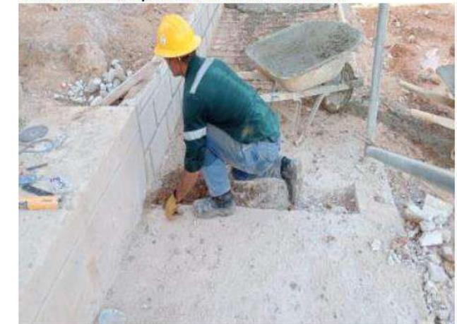
Fundida en concreto para andenes en rampa en el costado occidental
