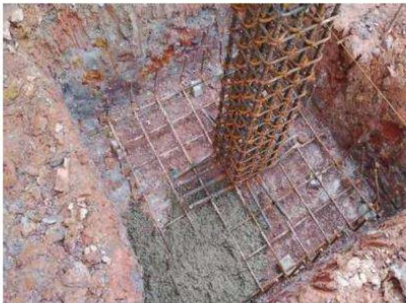
Instalación de acero de refuerzo para zapata y columnas.
