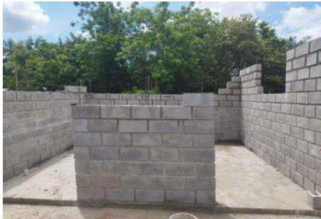
Levante en bloque de concreto estructural para el cuarto de máquinas
