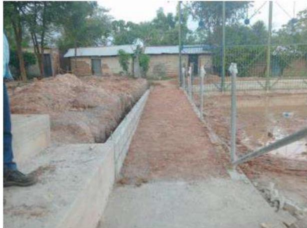
Relleno y compactación de material común para andenes en rampa en el costado occidental
