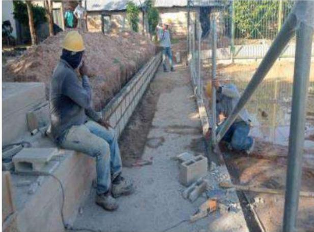
Levante en bloque de concreto para muros de andén en rampa en el costado occidental
