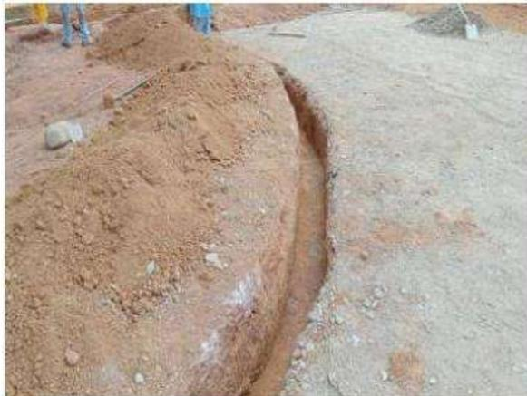
Excavación de material común para dentellón de losa de contrapiso del parque infantil
