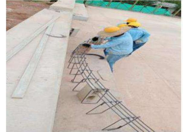
Figuración de acero de refuerzo para dentellón de losa de contrapiso en el parque infantil
