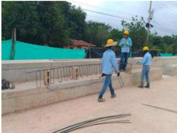
Figuración de acero de refuerzo para dentellón de losa de contrapiso del parque infantil
