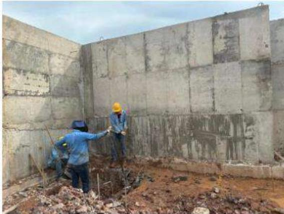
Excavación de material común para zapatas de la tarima de espectáculos
