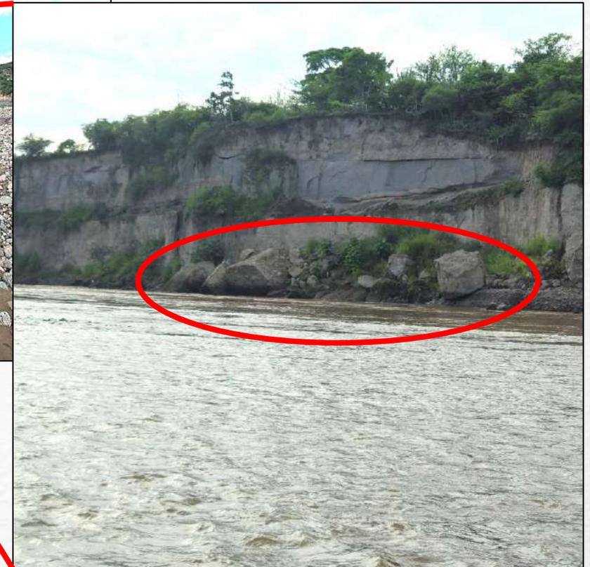
Presencia de bloques provenientes del talud contiguo al embalse, con diámetros equivalentes superiores a 1m
