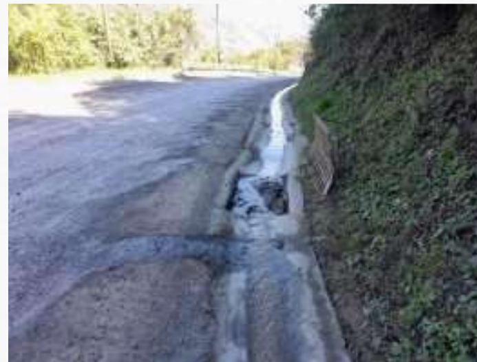
Caja de inspección con tubería tapada en el K1+670
