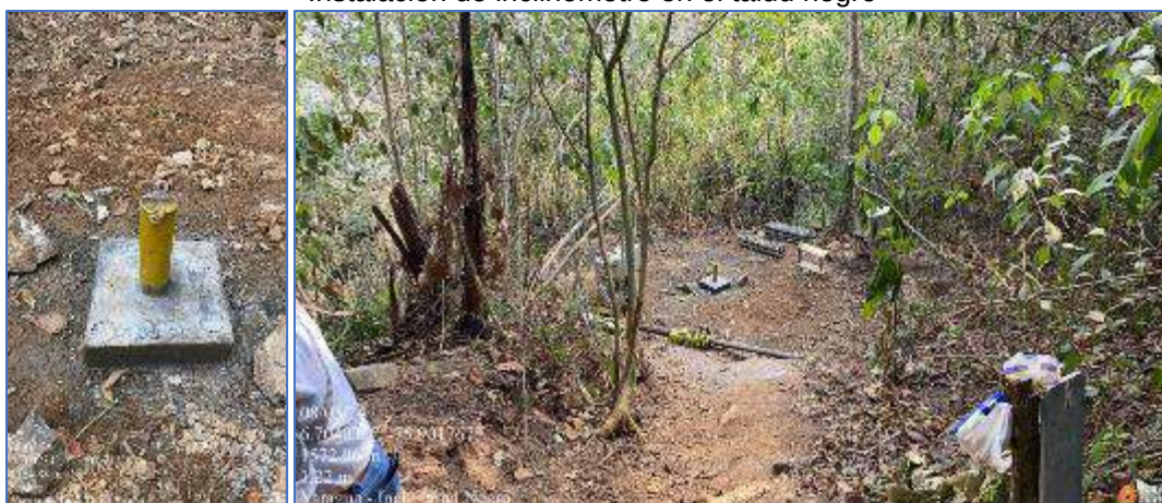
Instalación de inclinómetro en el talud negro
