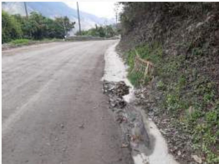
Caja de inspección con tubería tapada en el K1+670
