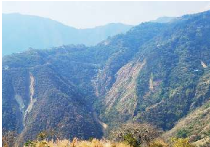
Fotografía 33. Panorámica del área de área erosionada por el manejo de agua Coordenadas: E 4679388,511; N 2301498,709 Origen Único Nacional
