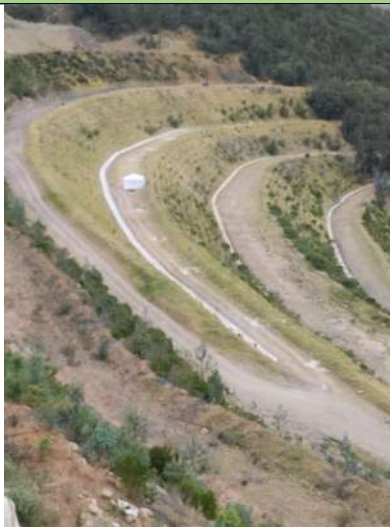
Figura 18. Cuneta construida sobre la Terraza 3 Fuente: Holcim Colombia, 2022
