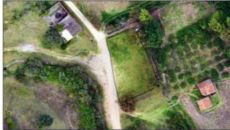
Imagen 2. Área de mantenimiento exterior
