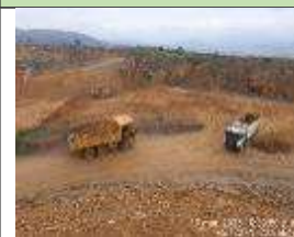
Fotografía 5. Área de retrolenado
