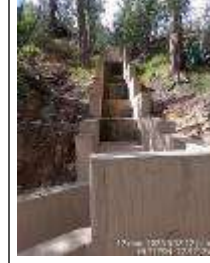
Fotografía 14. Estructuras disipadoras de energía
