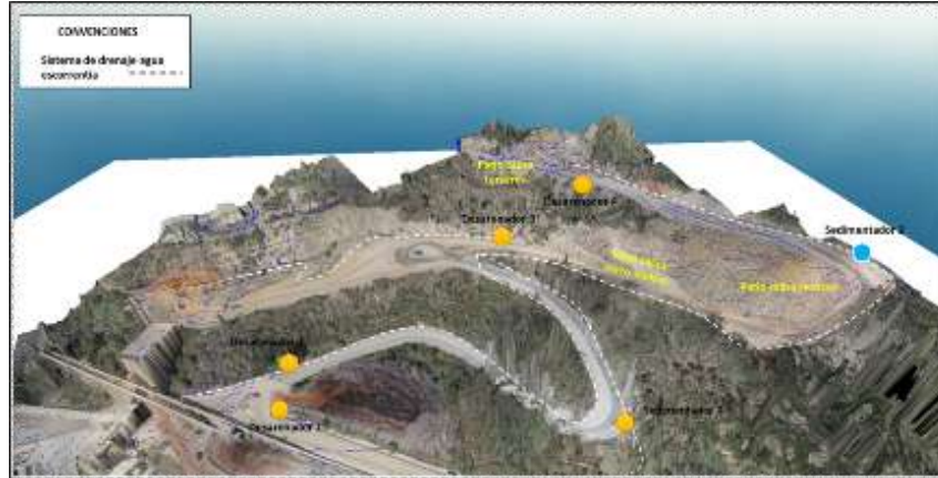
Figura 9. Sistema de drenaje mina Nobsa
