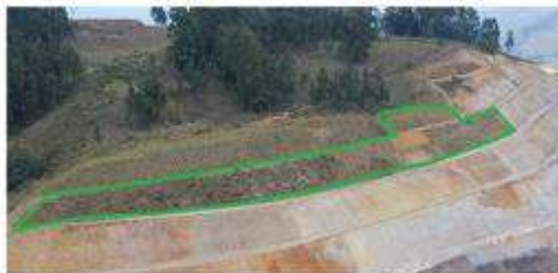
Zona 1 TALUD FINAL ZONA DE EXPLOTACIÓN
