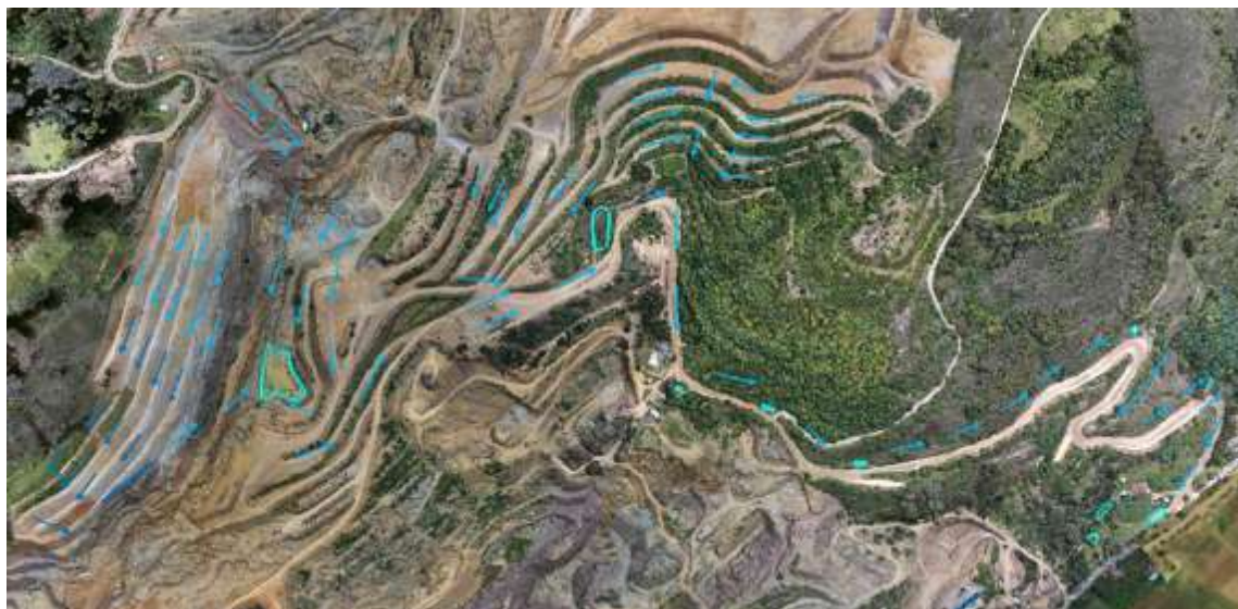
Figura 6. Sistema de drenaje mina Suescún
