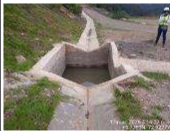
Fotografía 14. Estructuras disipadoras de energía
