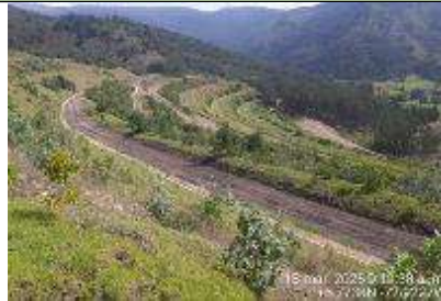
Fotografía 12. Cunetas pie de talud – Zodme Nobsa
