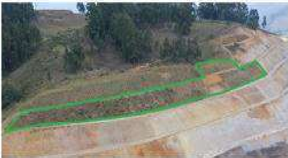
Zona 1 TALUD FINAL ZONA DE EXPLOTACIÓN
