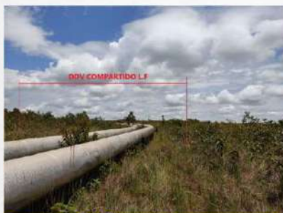
Fotografía 2-28 Derecho de vía compartido (Línea de flujo+ Línea de flujo)
