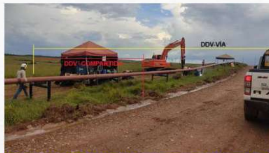
Fotografía 2-29 Derecho de vía compartido (Línea de flujo+ Vía de acceso)
