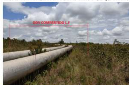
Fotografía 2-28 Derecho de vía compartido (Línea de flujo+ Línea de flujo) Fuente: SGI S.A.S, 2024.
