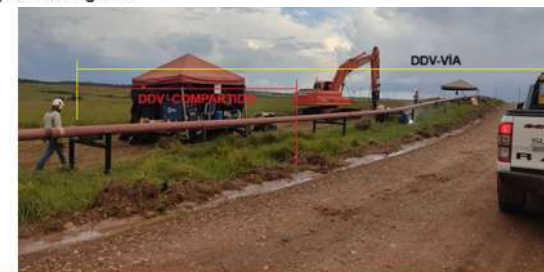
Fotografía 2-29 Derecho de vía compartido (Línea de flujo+ Vía de acceso) Fuente: SGI S.A.S, 2024.
