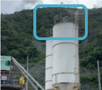
Fotografía M5-6. Filtros en silos de planta de concreto
