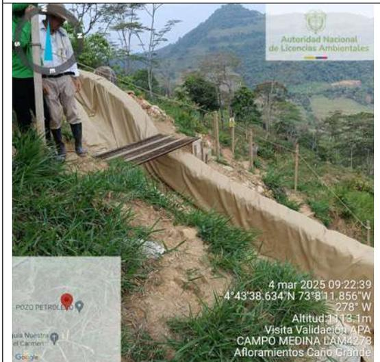
**Detalle obras para el manejo de aguas de escorrentía en parte alta del talud.
