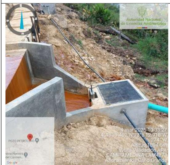
**Tubería para conducción de fluidos contaminados**
