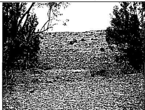
Botadero 2 activo. Obsérvese el pedraplen, la conformación de terrazas, la barrera viva con árboles adultos y algunos arbustos prosperados por regeneración natural.
