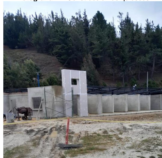
Fotografía 11. Construcción de quioscos
