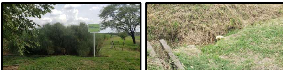
Fotos 3 y 4. Filtro Fitopedológico y punto vertimiento en canal en tierra.
