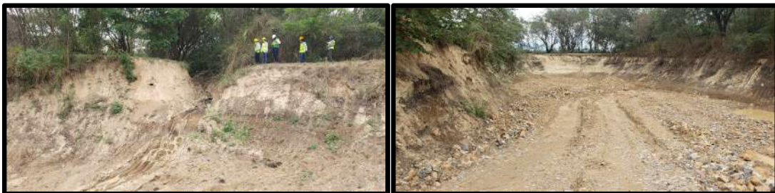
Fotos 10 y 11. Laguna sedimentación sin revestimiento para evaporación e infiltración a suelo.
