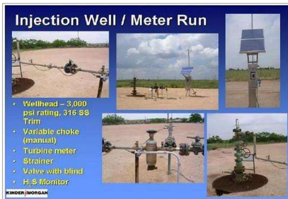
Figura 2-36 Ensamble tipo en superficie – pozo inyector de CO 2
