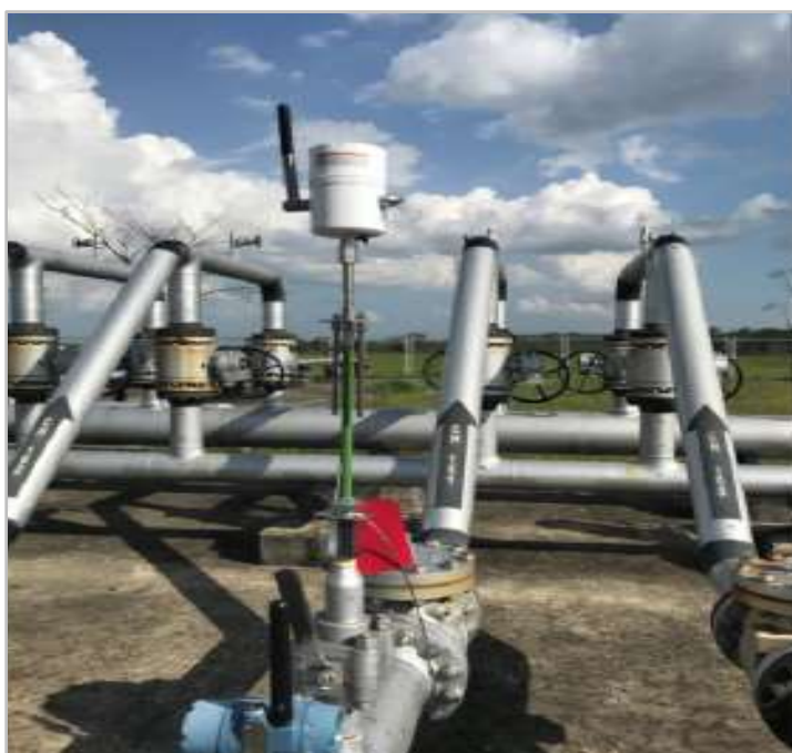
Figura 2-39 Probetas microcorr wireless Campo Chichimene Fuente: Ecopetrol S.A., 2022.
