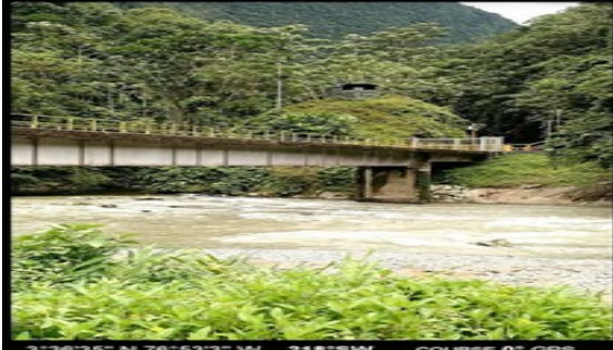
Fotografía 19. Vista del puente en la confluencia Quebrada la Riqueza en el Río Anchicayá
