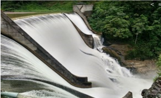
Fotografía 21. Vista de la descarga del agua de vertedero
