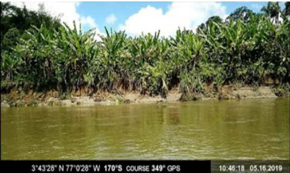
Fotografía 49. Socavación de orillas en el CCCN Llano Medio
