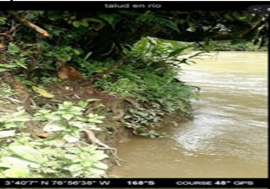
Fotografía 51. Talud del río Anchicayá el material del suelo no se observa con lodos oscuros, sino material rojizo
