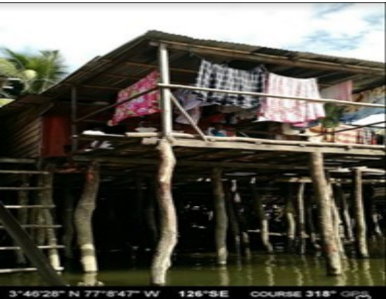
Fotografía 26. Construcción palafítica en la vereda Las Contrás
