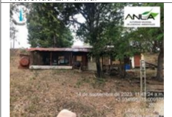
Fotografía Infraestructura de captación existente del predio Hacienda El Palmar
