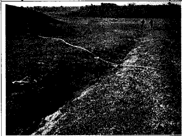
Fotografía 110: Escurrimiento de la vía hacia las zonas más bajas
