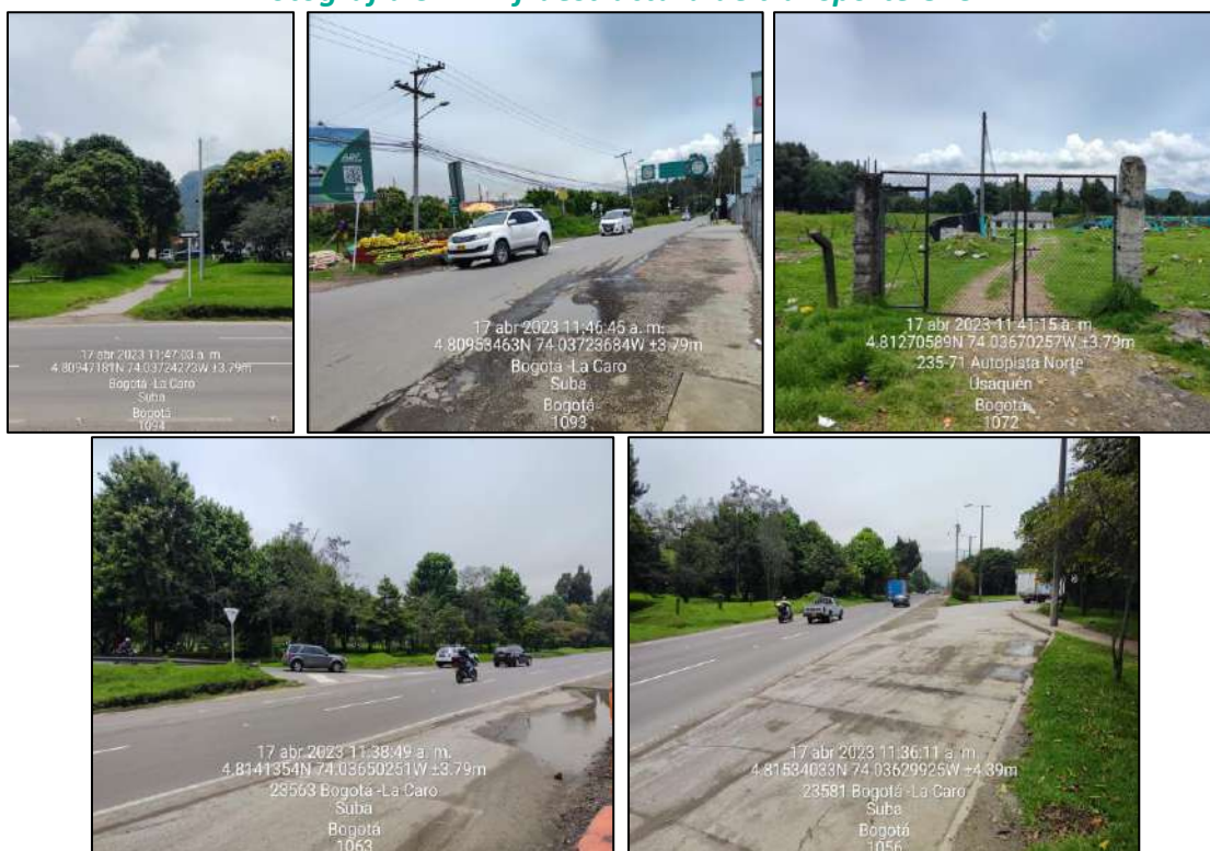
Fotografía 3-11 Infraestructura de transporte UF3
