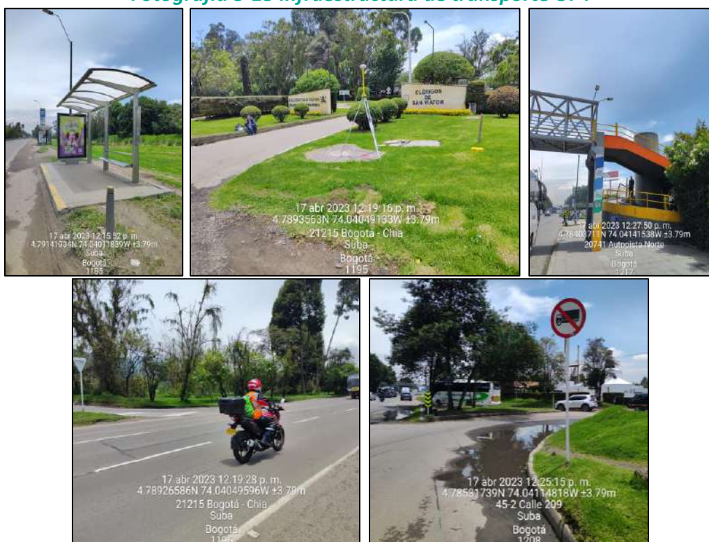
Fotografía 3-13 Infraestructura de transporte UF4
