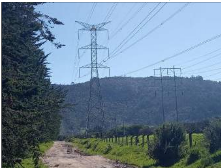
Fotografía 5-4 Elementos discordantes asociados a torres de transmisión de energía. Coordenadas E 4884549,097 N 2086134,983
