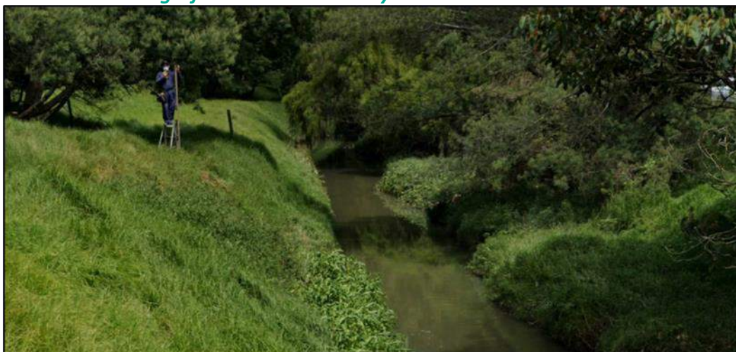
Fotografía 5-2 Canal de Guaymaral a la altura de Bima
