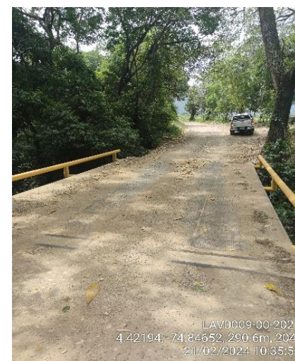
Vía de acceso que conecta la cabecera municipal de Coello con la plataforma EFP.
