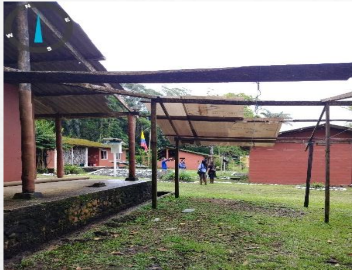
UBICACIÓN ESTACIÓN GUARDACOSTAS
