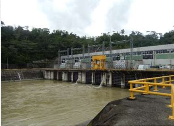
SALIDA TÚNELES DE DESCARGA
