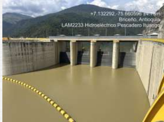
Parte anterior del vertedero con estructura de compuertas
