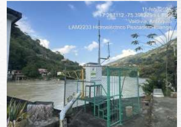
Estación de monitoreo (caudales) de Puerto Valdivia
