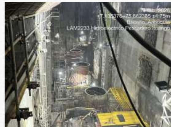
Estado de avance unidades de la 5 a la 8
