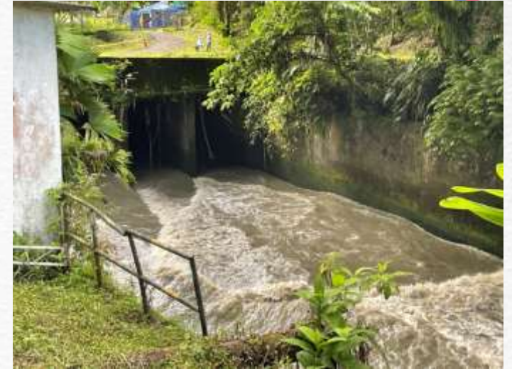
CANAL DE AGUAS TURBINADAS
