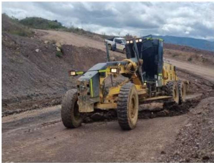
Mantenimiento de vías internas con motoniveladora mina Suescun 2024
