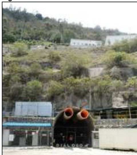
Fotografía 2-1 Huella Área del Portal El Emboque
