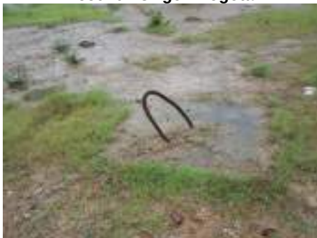
Fotografía 15 Anclaje. E: 1090455, N: 1559462 Origen Bogotá
