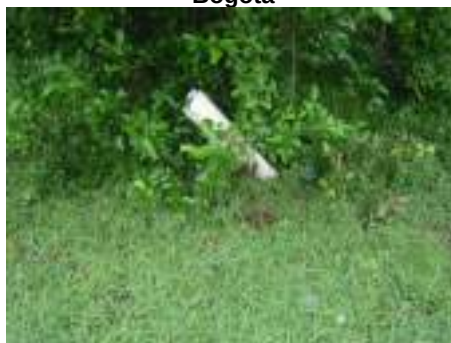
Fotografía 4 Tubería inspección filtro piscina. E: 1090348, N: 1559560 Origen Bogotá
