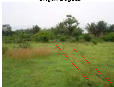
Fotografía 6 Cunetas de aguas lluvias obstruidas. E: 1090348, N: 1559560 Origen Bogotá
