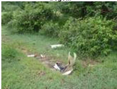
Fotografía 14 Tubería inspección filtro piscina. E: 1090455, N: 1559462 Origen Bogotá
