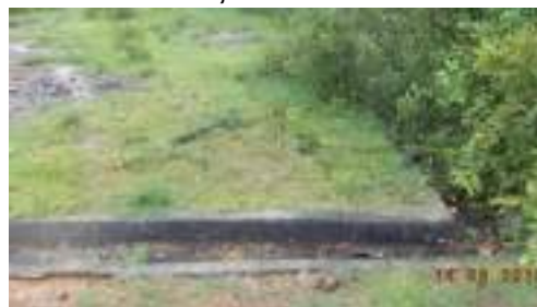
Fotografía 23 Cunetas existentes en la locación del pozo IRACA B-1X – E:1090437, N:1559489 MSBta
