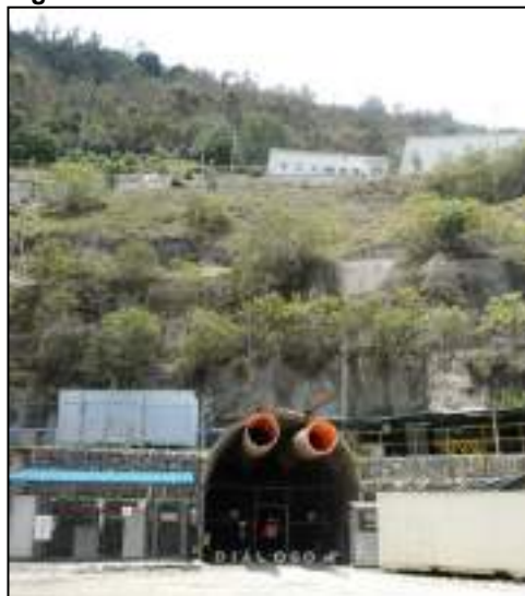
Fotografía 2-1 Huella Área del Portal El Emboque
