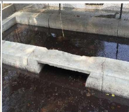
Foto N° 18. Agua de los cubículos colmatada de lodos.
