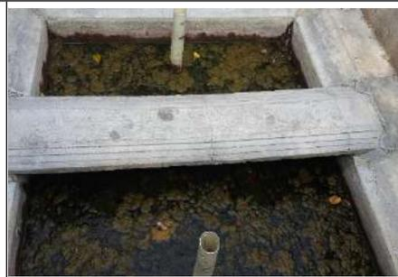
Foto N° 12. Agua de los cubículos colmatada de lodos.
