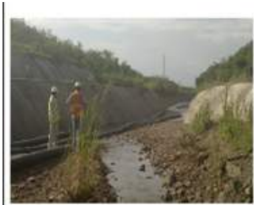
Foto 1: vista de la parte inicial del canal de desvío del caño Canime, nótese las mangueras que conducen agua bombeada del pit norte.
