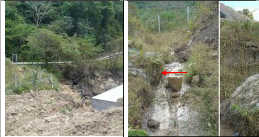
Fotografía 26. Box Culvert entre el K48+372 y el K48+813. Se evidencia el derrame de concreto sobre ronda y curso de quebrada.
