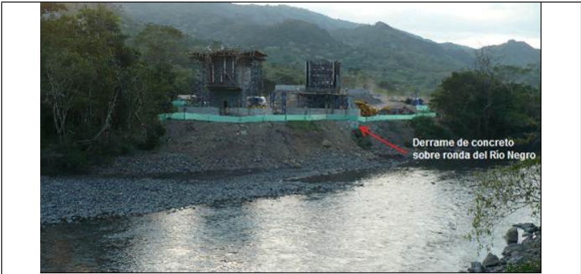
Fotografía 25. Construcción apoyos del puente río Negro bajo. Derrame de concreto aproximadamente en el K43+258. Coordenadas Magna Sirgas Bogotá: Este: 945508,80, Norte: 1074706,64.
