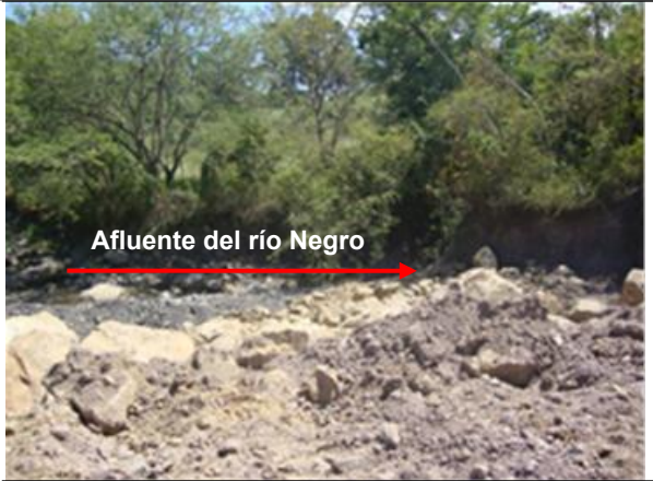
Fotografía 31. Afluente del río Negro, obstruidos por disposición inadecuada de material sobrante de excavación, (junio/2012).
