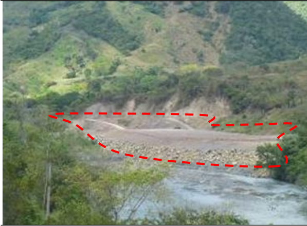
Fotografía 32. Sitio de disposición de material sobrante sobre la ronda del río Negro y ocupación de cauce, vista desde el corredor proyectado al otro lado del río, (junio/2012).
