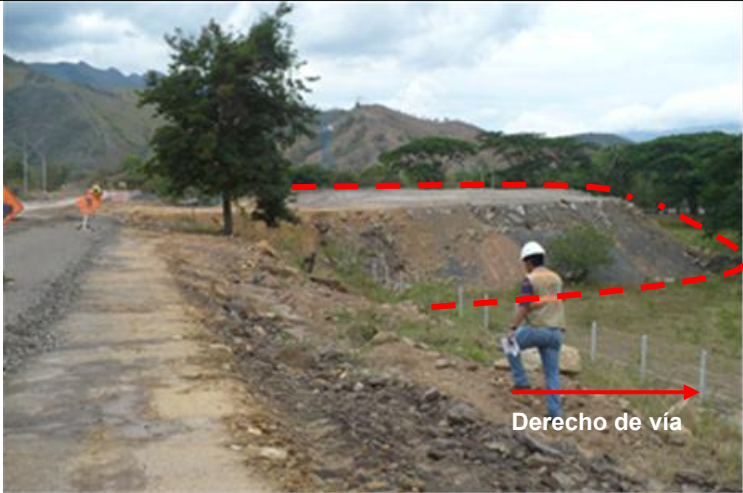
Fotografía 37. Conformación sitio de disposición de material sobrante en el K34+520, (agosto/2012).
