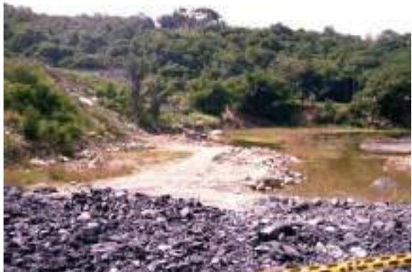
Fotos 10 y 11. Aguas represadas de la quebrada La Golondrina, por el cierre del meandro del río Sumapaz y la ausencia de estructuras que permitan que durante el desarrollo de las obras el agua drene permanentemente.
