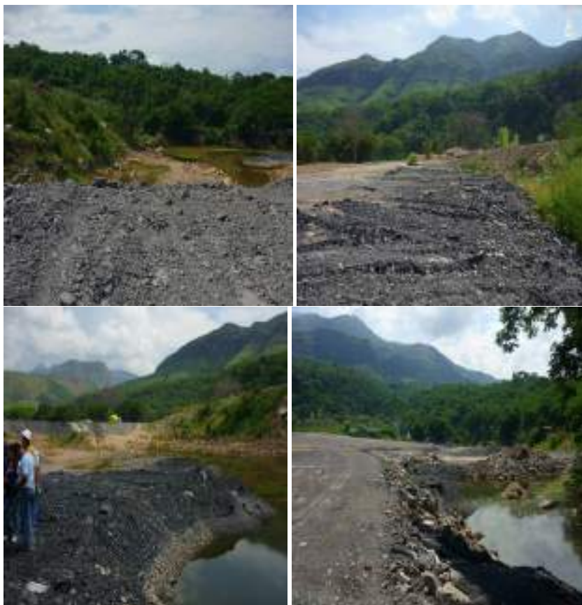
Fotos 14 a 17. Disposición y extendido de material dentro del área aislada por el jarillón y fuera del corredor ya disponible y necesario para la conformación de la calzada proyectada dentro de los diseños de la glorieta.
