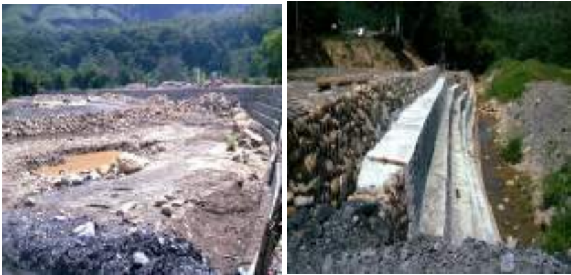
Fotos 6 y 7. Gaviones contruidos para cerrar el meandro del río Sumapaz
