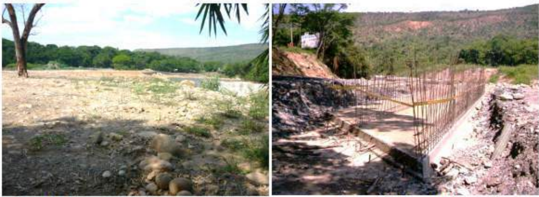
Fotos 8 y 9. Corona de tránsito de maquinaria conformada tras los gaviones y obra de arte en construcción a un extremo del gavión para dar paso a las aguas de la quebrada Golondrina. Se observa que el ancho de la obra es suficiente para permitir el desarrollo de la calzada proyectada para la glorieta, siendo de las mismas dimensiones que la corona para el tránsito de la maquinaria con la cual construyen los gaviones. (Negrilla fuera del texto original).
