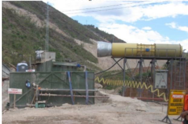
Foto 7. Acondicionamiento del sistema de tratamiento de aguas residuales industriales en la planta de concretos de la rotonda en Ventana 1
