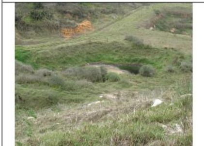
Fotografía 20 Antigua piscina de lixiviados, sin recubrimiento de fondo y lateral. Coordenadas Magna Sirgas Origen Bogotá E: 976888 - N: 1006078
