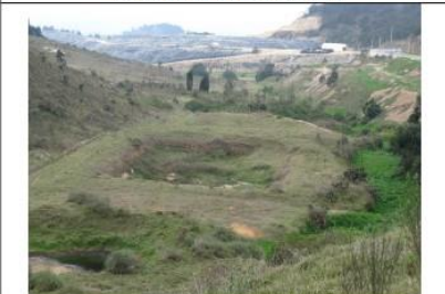
Fotografía 22 Antigua laguna de homogenización de lixiviados. No cuenta con revestimiento y se observa sin presencia de lixiviados. Coordenadas Magna Sirgas Origen Bogotá E: 976877 - N: 1006024
