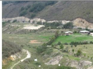
Fotografía 26 Área en el costado sur del botadero con algunas chimeneas para extracción de gas.
