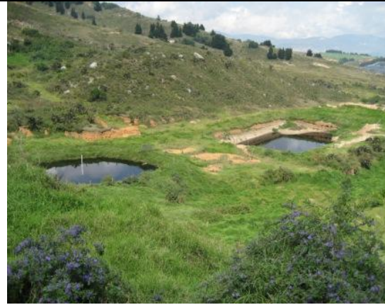
Foto 10. Vista general de los “reservorios” de lixiviados que dan hacia el relleno Nuevo Mondoñedo. Al fondo se evidencia un desprendimiento de material y la inexistencia de revestimientos
