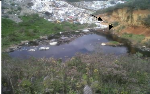
Foto 3. Zona de vertimiento de lixiviados favorecido por la escorrentía de aguas lluvias
