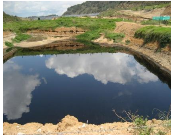
Foto 12. Reservorio de lixiviados donde se nota que no tiene recubrimiento en las paredes, y la presencia de procesos erosivos y de remoción en los perímetros de la misma.
