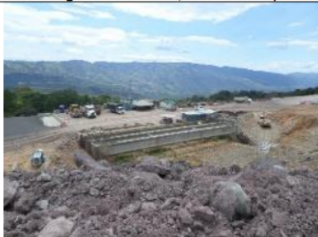
Fotografía 13 Instalación Puente-Peaje. (Coordenadas planas magna sirgas origen Bogotá E944181.44, N1056329.46)
