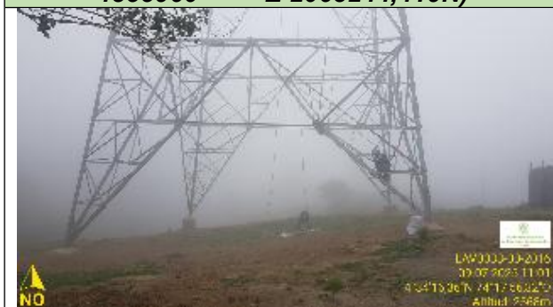
Fotografía G14 sitio de torre 302. (Coordenadas planas origen único 4855960 E 2063244,419N)
