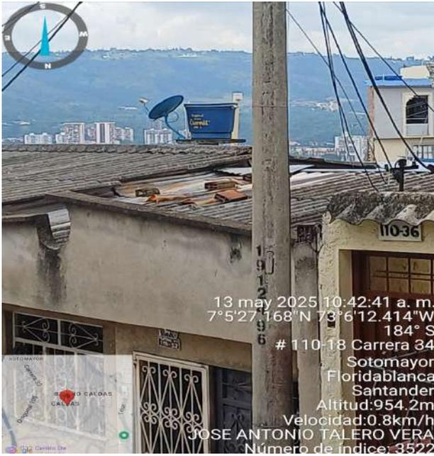
Vista parte exterior de la casa el Punto de descarga en tubo PVC de la chimenea artesanal del horno, sin las más mínimas normas de control del manejo de los gases y vapores generados durante el proceso de fundición, para que con buenas prácticas de ingeniería contrarrestar las presuntas emisiones fugitivas del material particulado, por ende, acatar lo inmerso en Artículos 68, 69 y 70 Resolución 909/2008 y Artículo 23 Decreto 948/1995
