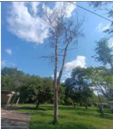
Foto 3: se evidencia infraestructura y riesgo a transeúntes.
